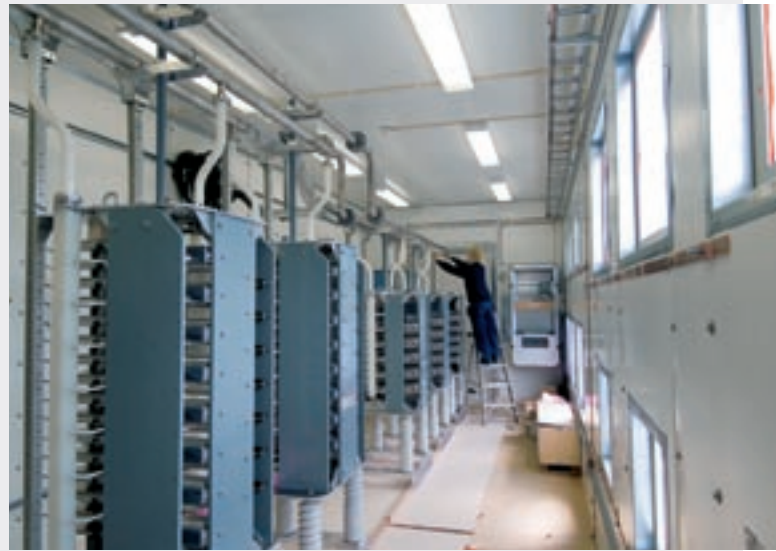
Interiör från thyristorhallen i den franska kraftnätsoperatören RTE's modul. Interior view of the thyristor room in the french power grid operator RTE's module.
