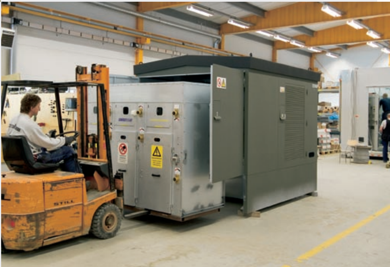
Ställverk som monteras in i transformatorbyggnad. Switchgear mounted into transformer building.
